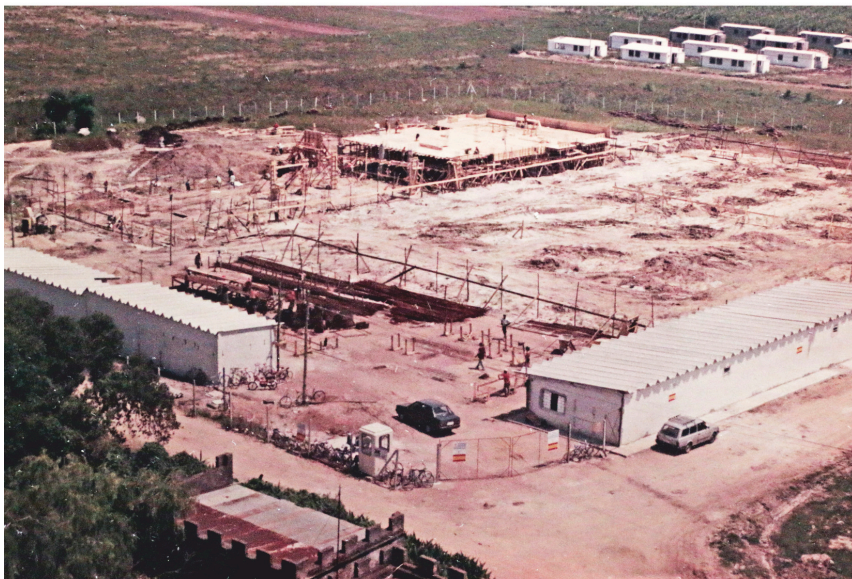
Fotografía obra en etapa de cimentaciones, tomada desde el techo del tanque de OSSE Archivo del Hospital de Canelones
