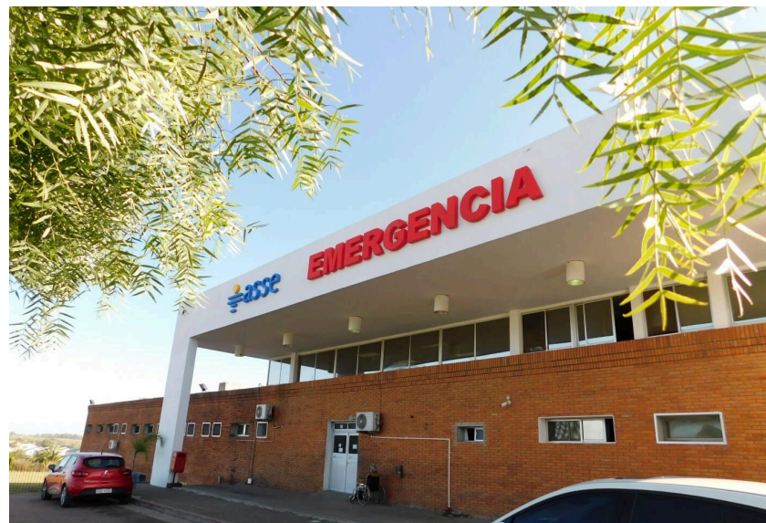
Imagen de la emergencia del Hospital de Canelones 2020
