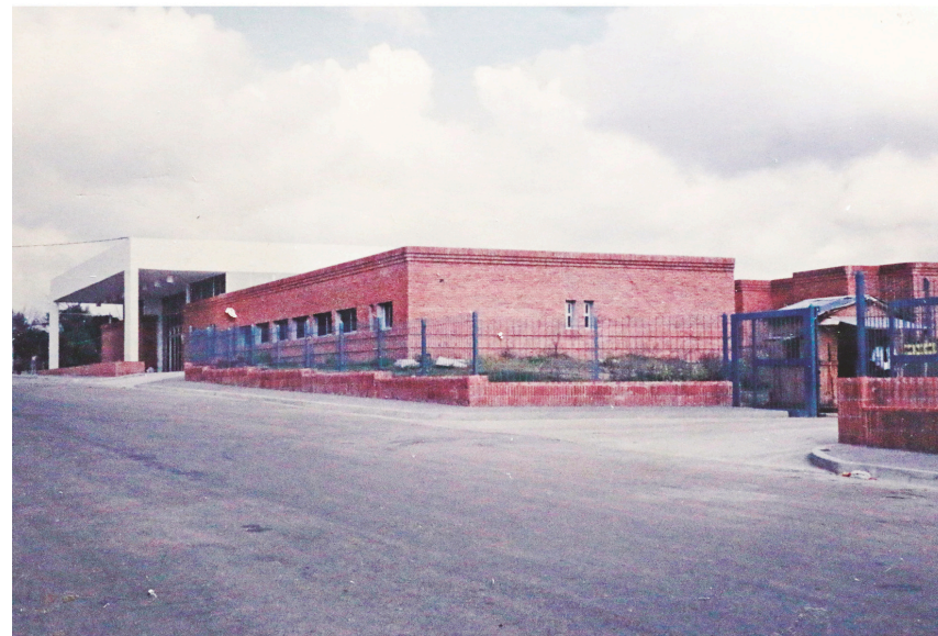
Fotografía fachada principal Hospital actual antes de la inauguración. Archivo del Hospital de Canelones.
