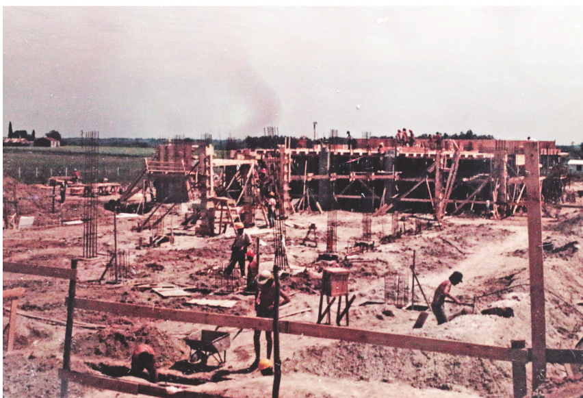
Fotografía obra en etapa de cimentaciones. Archivo del Hospital de Canelones
